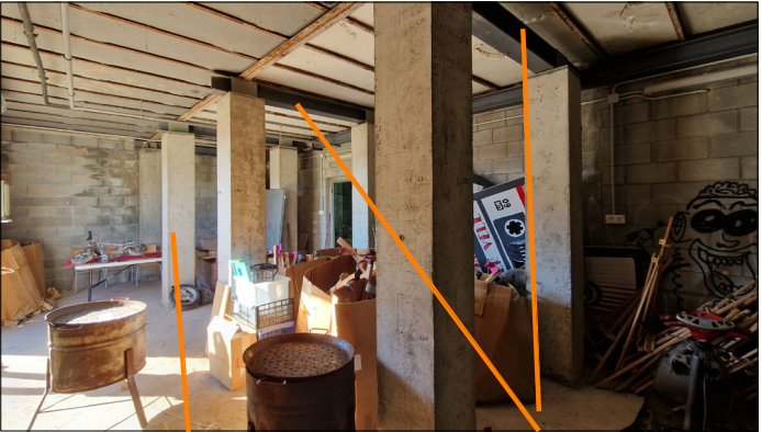
Cambra sanitària. Pilars formigó armat, Estris a retirar i perfils HEB 180. Paviment formigó
